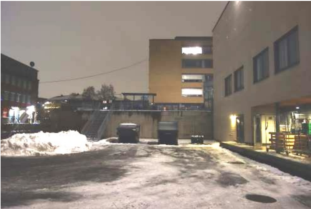
OBOS-garasjen (tak på nivå med øvre gårdsplass) - sett fra nedre gårdsplass.
